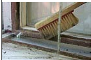
Фото 7. Удалить пыль и грязь из под штапика
