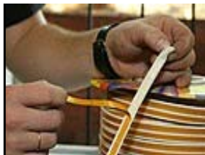
Фото 11. Снять защитную ленту с уплотнителя
