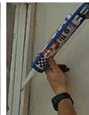
Фото 10. Можно нанести герметик и на стык штапика и стекла
