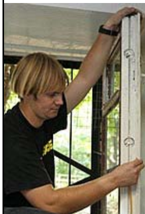
Фото 12. Отмерить уплотнитель по периметру окна...
