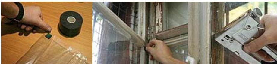
Фото 16. Наклеить на углы пленки кусочки двухстороннего скотча. Это упростит ее установку
