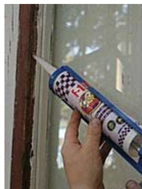
Фото 8. Нанести силиконовый герметик в место сопряжения стекла и рамы
