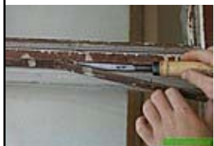
Фото 6. Снять штапик, вынуть стекло из рамы
