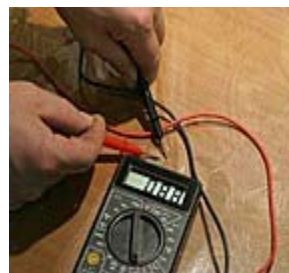
Фото 15. Вырезать пленку по размеру рамы, найти электропроводящую сторону пленки с помощью тестера (при установке она должна «смотреть» на улицу). Это же правило действует и при установке теплоотражающего экрана за радиатор отопления
