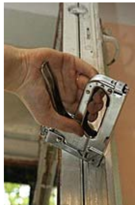
Фото 14. Концы уплотнителя можно закрепить гвоздиками, кнопками или скобами с помощью строительного степлера
