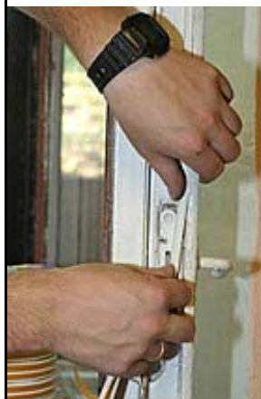
Фото 13. ... и наклеить его на раму
