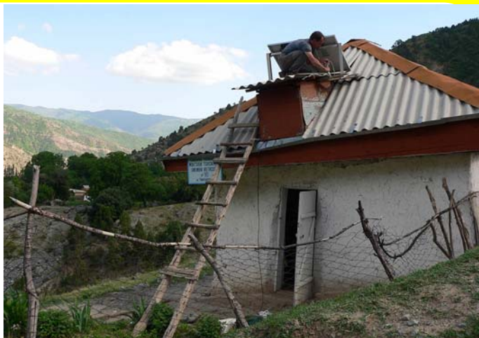
на фото: установка солнечных панелей на крыше школы в к. Лабиджай
