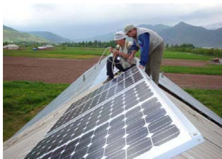
на фото: установка солнечных панелей на крыше больницы в кишлаке Нушор, Рашт
