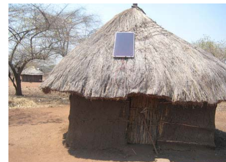
на фото: солнечная фотопанель на крыше обычного дома в Мозамбике
