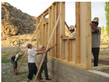
на фото: установка деревянного каркаса
