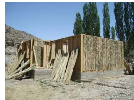
на фото: наполнение каркаса здания ФАПа камышом
